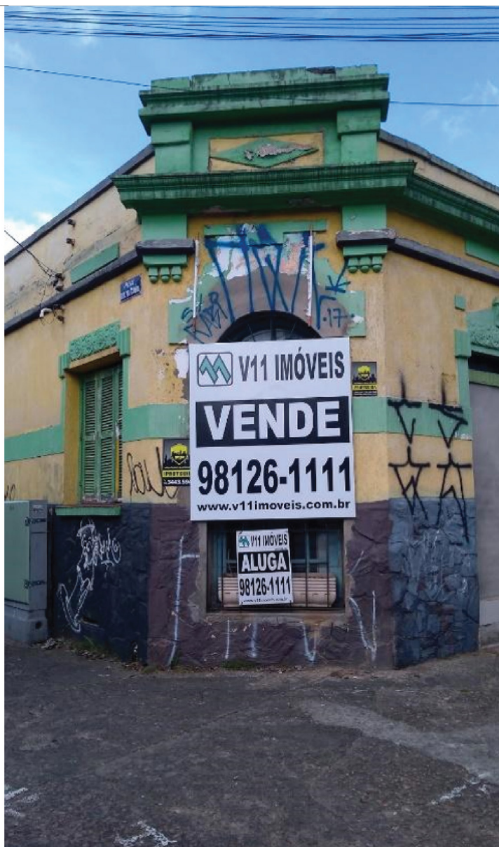
Figura 5. Imóvel não inventariado
