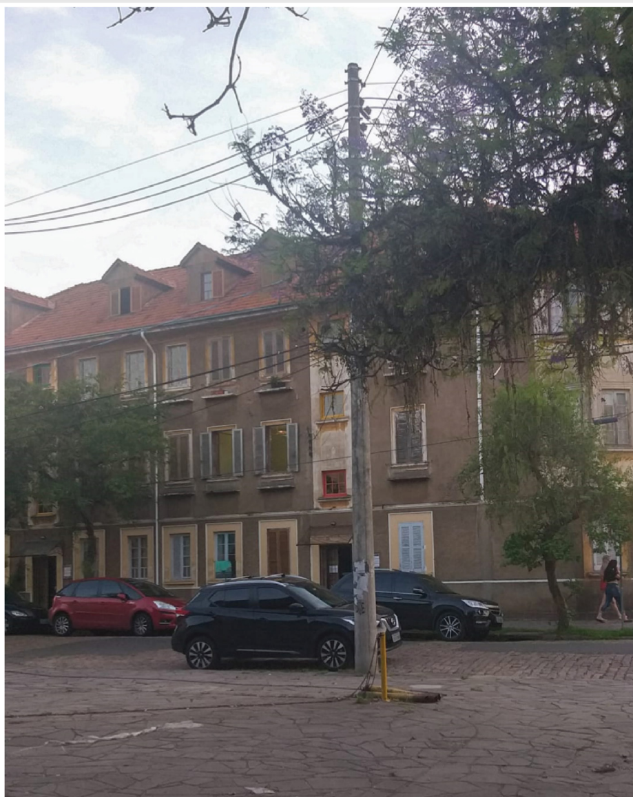
Figura 7. Patrimônio cultural no bairro Floresta – Imóvel de estruturação – Associação Cultural Vila Flores
