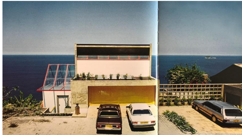
Figura 4: Fachada oeste da Casa de São Conrado, acesso principal. Fonte: Livro Janete Costa - Arquitetura, design e arte popular, 2000, p.147.
