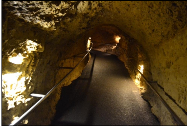
Figura 10 – Rampas adaptadas a pessoas com deficiência física dentro da caverna, com corrimão e piso antiderrapante.
