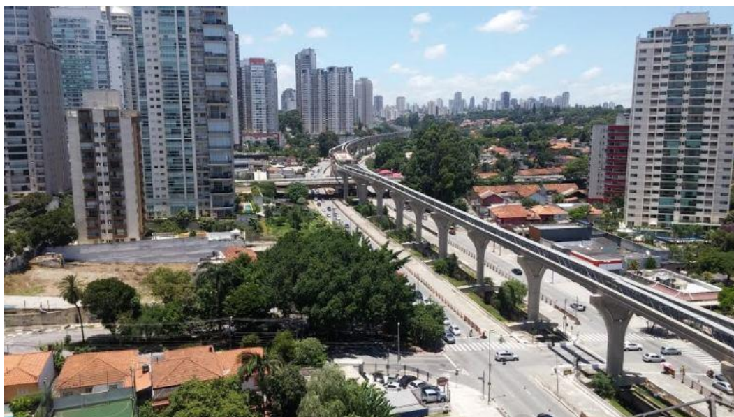
Figura 6 – Obras do monotrilho dentro do perímetro da OUCAE Fonte: Vagner Landi, 2017 5
