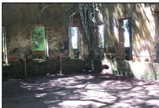
Figura 8 – Parte interna do edifício
