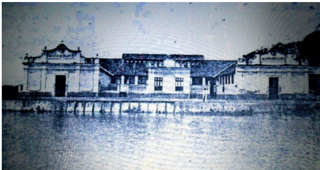
Figura 1- Prédio do antigo Matadouro. Atual Escola Municipal “Mário Andreazza”.
