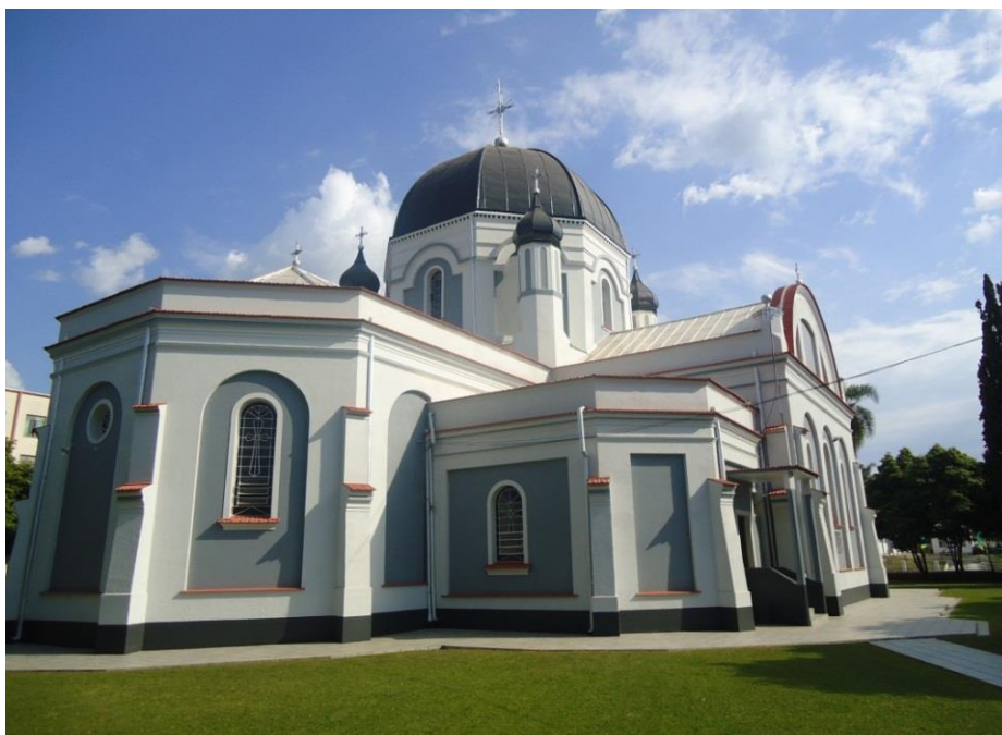
Foto nº4 ; Vista da matriz São Josafat em Prudentópolis (PR)
