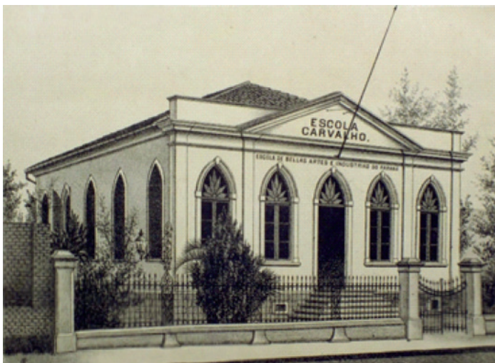
Figura 1 - Fachada da Escola Carvalho
