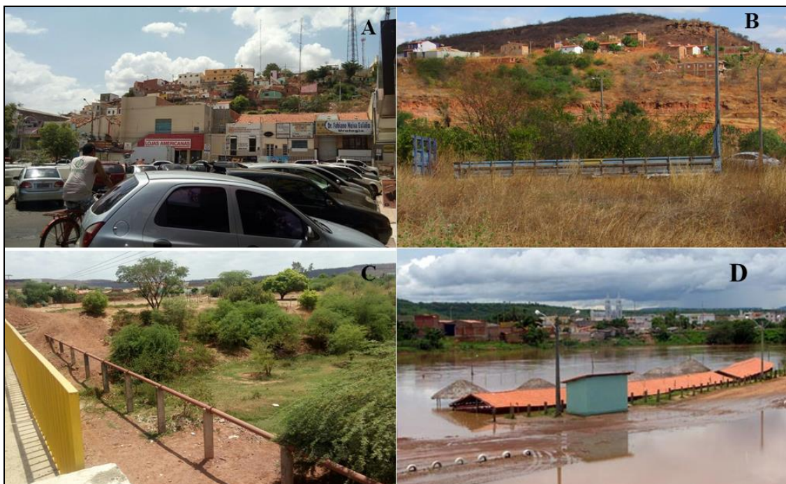
Figura 7 – Mosaico de fotos representando as limitações e vulnerabilidades do município de Picos. Em A e B, ocupação de áreas com relevo mais acentuado; em C, leito seco do rio Guaribas e em D, enchente do mesmo rio no ano de 2007.
