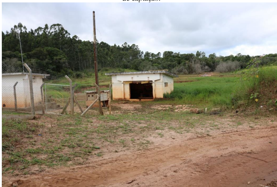
Figura 9 – Posto de captação de água inoperante no momento da pesquisa devido ao assoreamento do ponto de captação.
