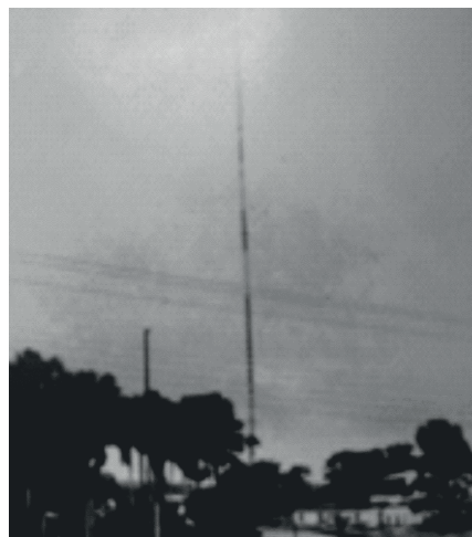
Figura 07 – Casa do Transmissor de Onda Média.
