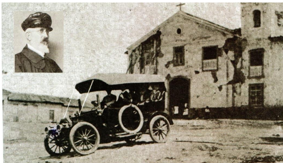
Figura 13: Henrique Bocolini (destaque) em vistoria à Igreja dos Jesuítas, para futura restauração em 1908.
